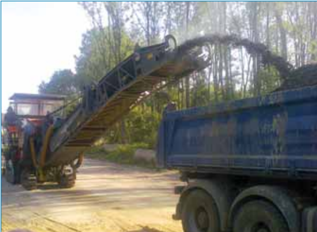
Sanieren, sanieren, sanieren...
