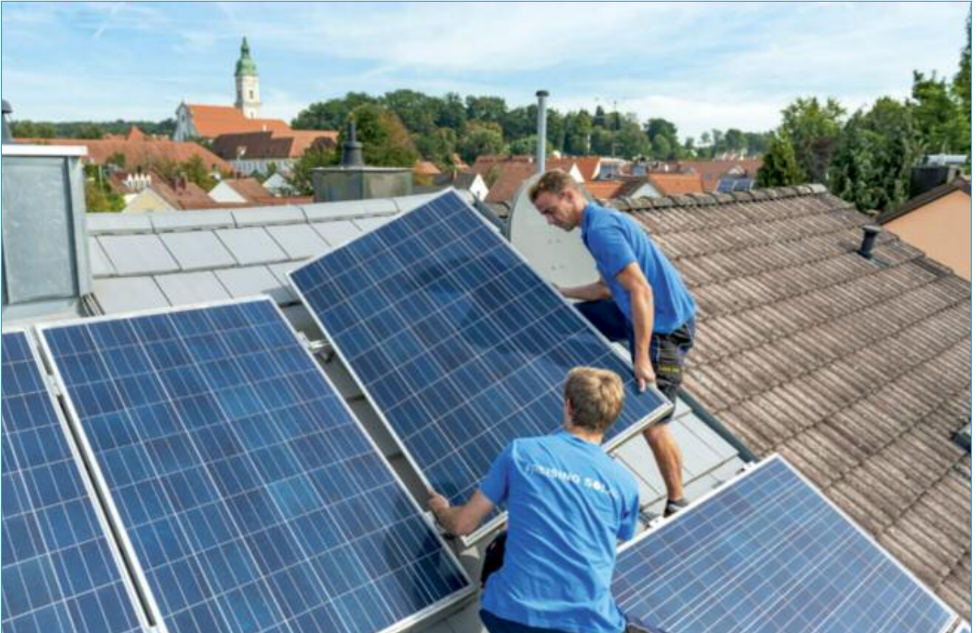
Installation von Solarmodulen auf einem Hausdach in Freising-Neustift.
