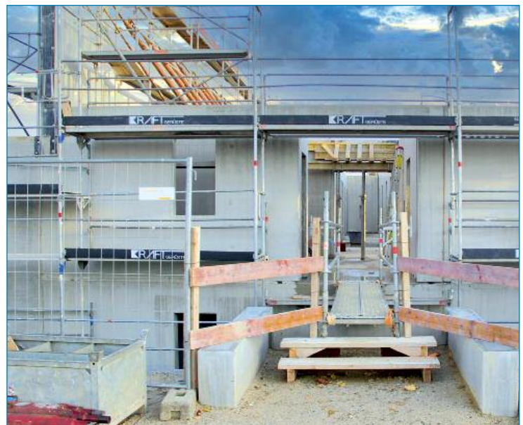
Haupteingang (Barrierefrei) zum Obergeschoß
