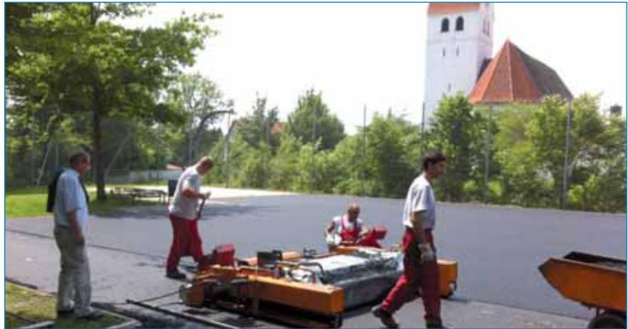
und nivelliert. Nach Auskühlen und Aushärten der Bindschicht wurde die neue, griffige Granulatschicht als Belastungsschicht wieder aufgebaut. Als letzter Punkt wurden die entsprechenden Spielfeldlinien wieder ergänzt, so dass der Hartplatz wieder in neuem und sicheren Gewand dem Sport zur Verfügung gestellt werden konnte. Der Austausch des Sandes aus
